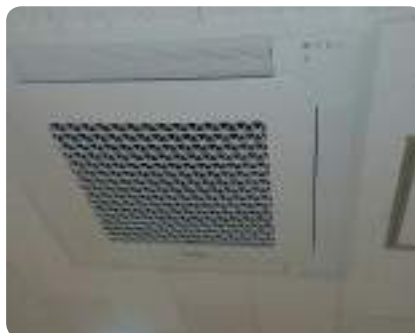
[12월] 1~3층 시스템 에어컨(EHP) 설치
