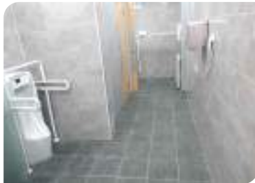
[12월] 1층 화장실 리모델링
